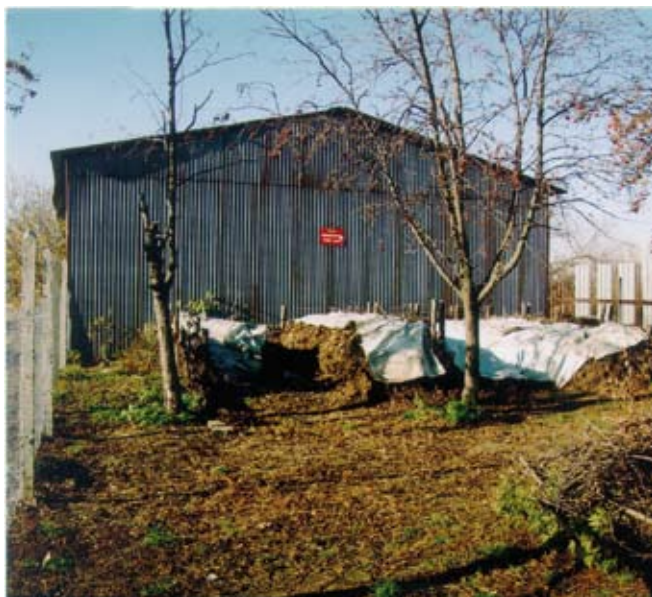
Obecní kompostoviště v obci Kokšov
