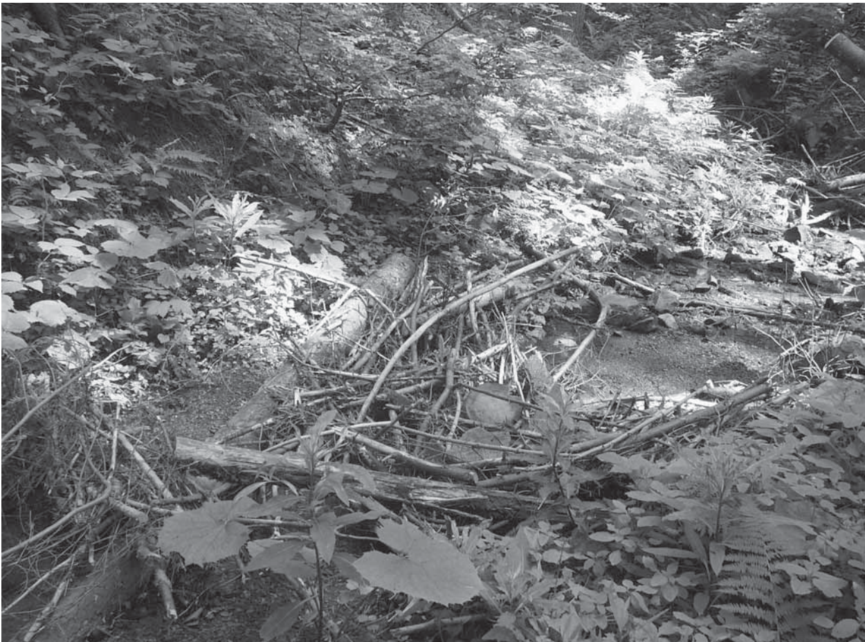
Obrázek 3: Jedna z dřevěných přehrad na potoce 1. řádu – Prudkém (Beskydy). Její stabilizaci zajišťuje kmen s průměrem 27 cm. Díky této přehradce dochází k usazování jemných frakcí sedimentů, jež by jinak byly transportovány dál po proudu. Potok překonává přehloubení, vzniká tak plocha pro rozliv povodní.
