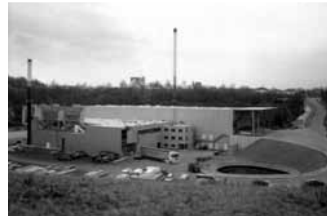
Zařízení na mechanicko-biologické zpracování odpadu v Drážďanech
